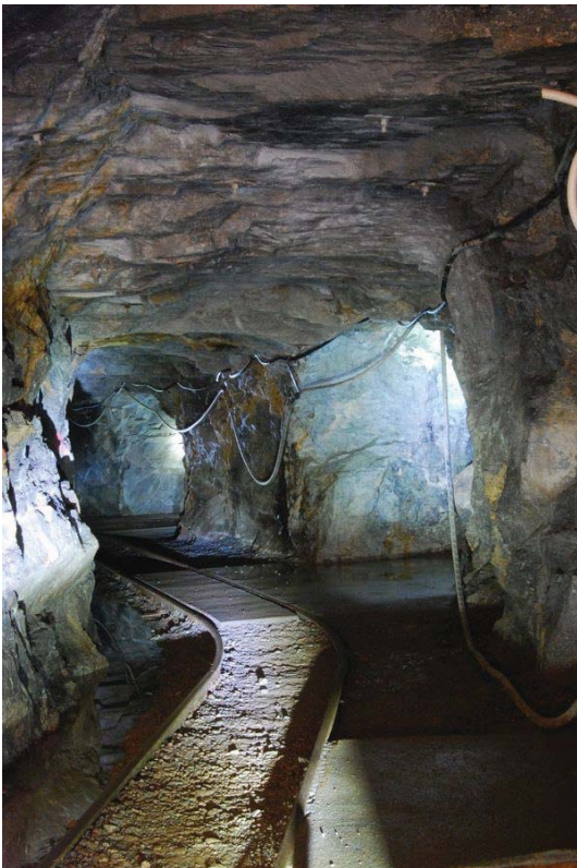
Abb. 5: Links eine der umliegenden Strecken des GFZ-Untertagelabors mit den Kammern an den Bohrlochpositionen (Foto: Grund). Die Hohlräume der Strecken bilden einen deutlichen seismischen Kontrast zum anstehenden Gestein. Das untere Bild zeigt einen Blick in eins der beiden Bohrlöcher.
