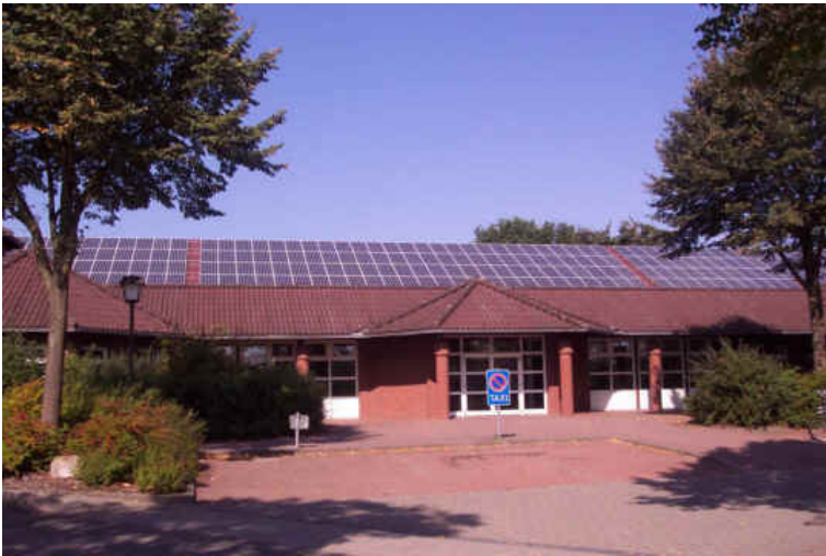
Abb. 2: Aller-Meiß-Halle (PV-Anlage auf dem Hauptschiff)
