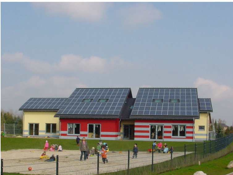
Abb. 3: Kindergarten Potsdamer Weg
