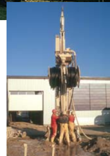
Bohren und Einbringen der Sonde
