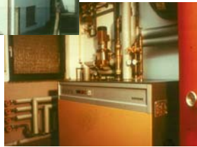
Frühes Beispiel mit Erdwärmesonden von Anfang der 1980er Jahre
