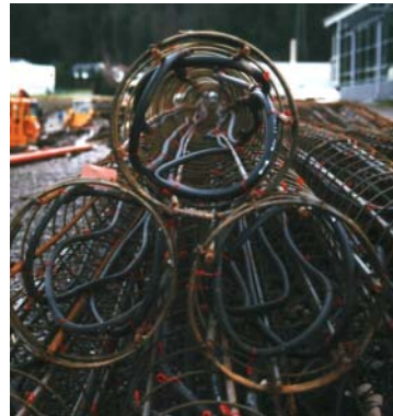
Vorbereitete Bewehrungskörbe mit Wärmetauscherrohren
