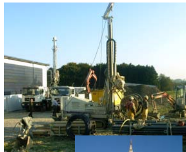
Bohren und Einbringen der Sonde
