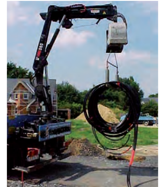
[Bild 13] Sondenrohr vor dem Einbau
