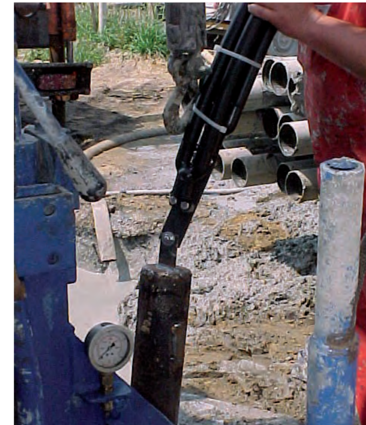
[Bild 32] Sondenfuß mit Gewicht
