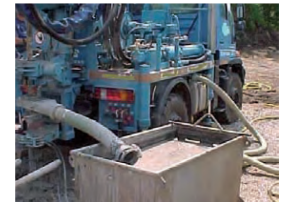
[Bild 28] Bohrfahrzeug mit Auffangbehälter
