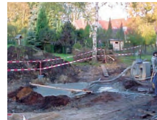
[Bild 27] Bohrschlammereinleitung in Mulde
