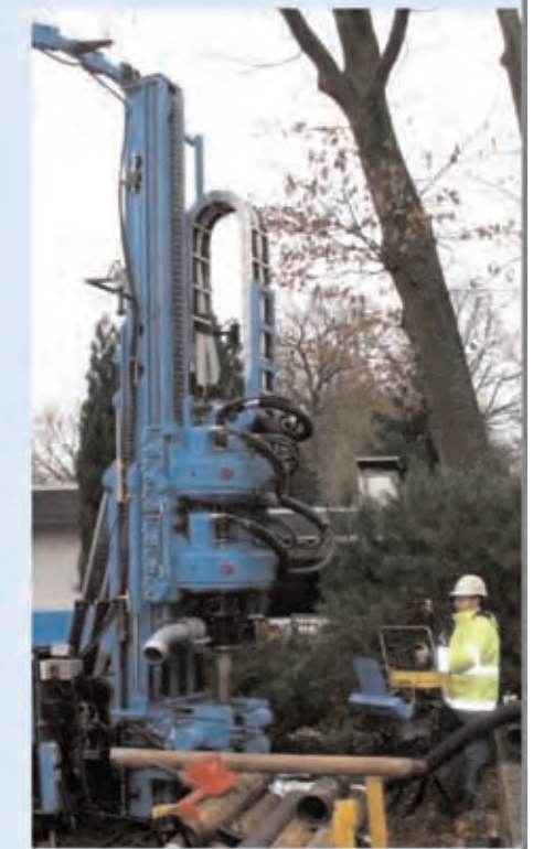
Erdwärmesondenbohrung Einfamilienhaus
