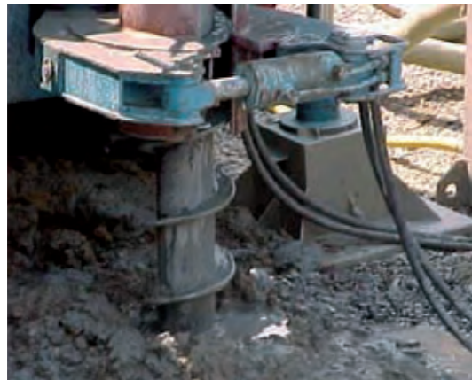
[Bild 25] Bohrfahrzeug während einer Bohrung
