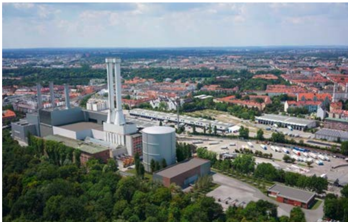
◀ Fig. 1 : La figure montre le site énergétique sud des Services Industriels de Munich (SWM) avec l'accumulateur de chaleur actuellement en construction (en blanc, au centre de l'image). Outre l'énergie classique produite au moyen de turbines à gaz et à vapeur, le réseau de chauffage urbain est alimenté par la chaleur géothermique depuis 2021.
