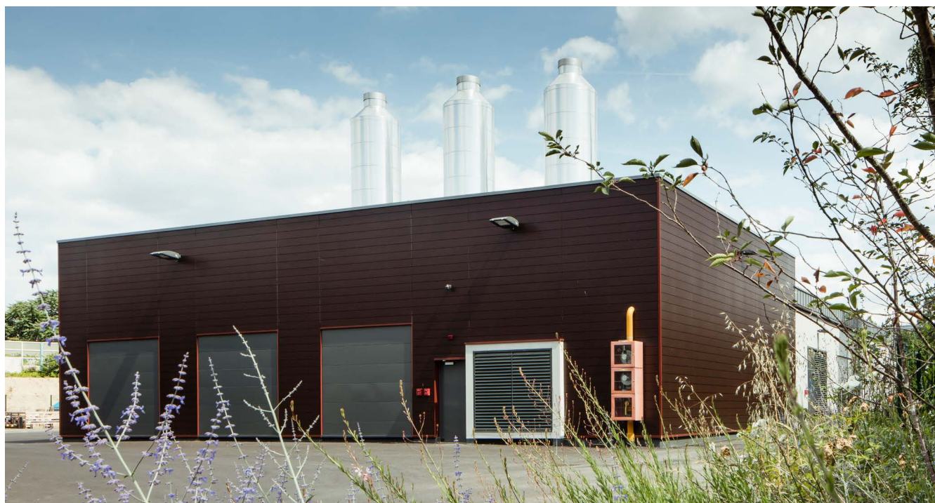
▲ Fig. 1: Centrale géothermique ArGéo d'Arcueil et de Gentilly
