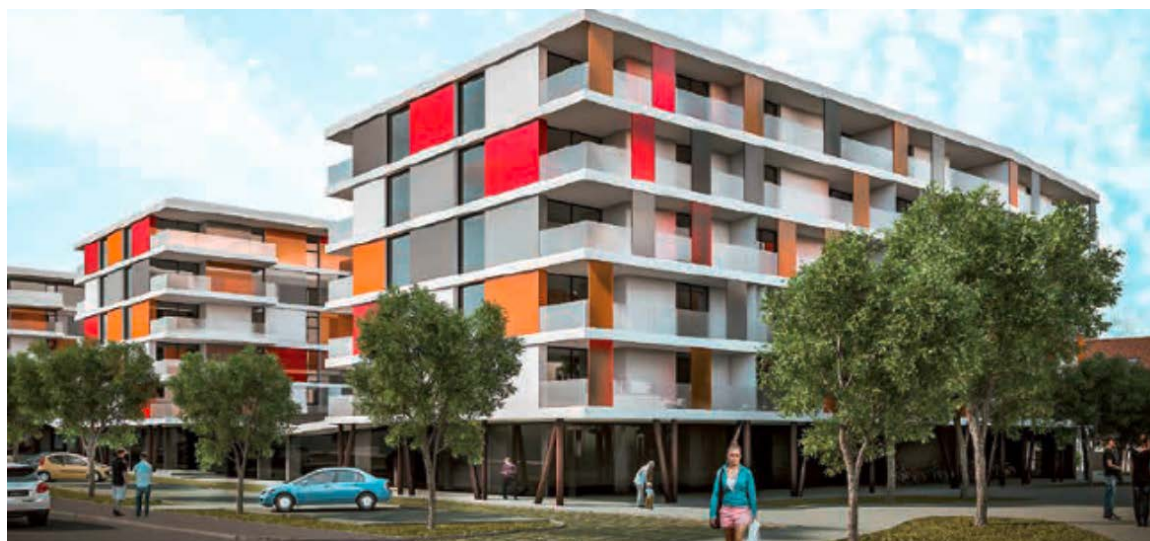
◀ Fig. 1: Le Quartier des Jardins de la Pâla à Bulle : le système retenu par respect aux énergies renouvelables est la géothermie sur nappe phréatique
