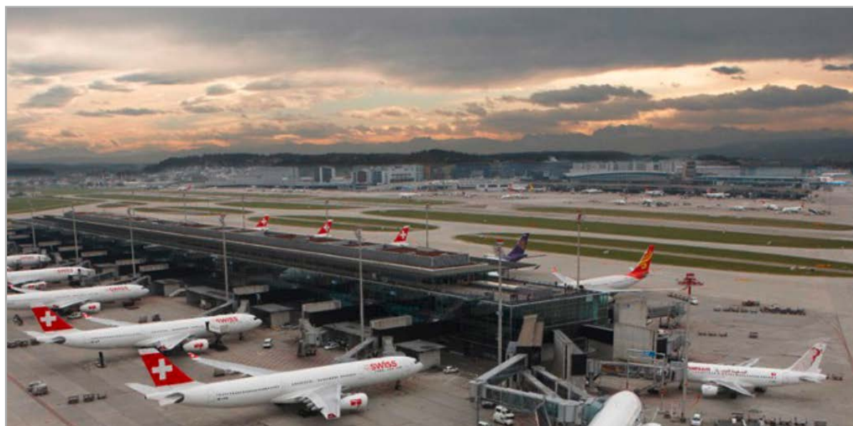
▲ Fig. 1: L'aéroport de Zurich mise sur la géothermie pour ses nouveaux bâtiments - ici le terminal E.
